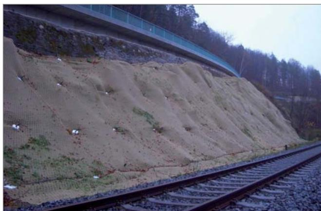
Bild 15: fertiggestellte Hangvernetzung
