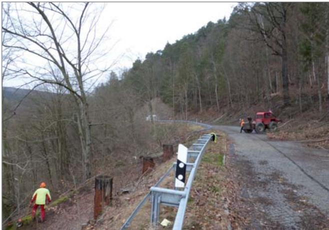
Bild 10: Baumfällarbeiten, Fahrzeug mit Seilwinde zum Bergen der Bäume
