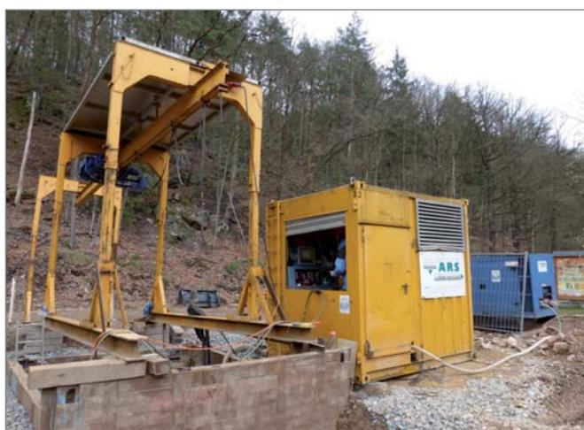
Bild 16: Schaltzentrale Microtunneling-Verfahren DN 600
