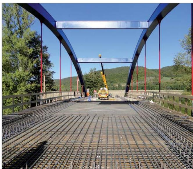
Neuer Brückenüberbau mit teilweise verlegter Bewehrung der Verbundfahrbahnplatte
