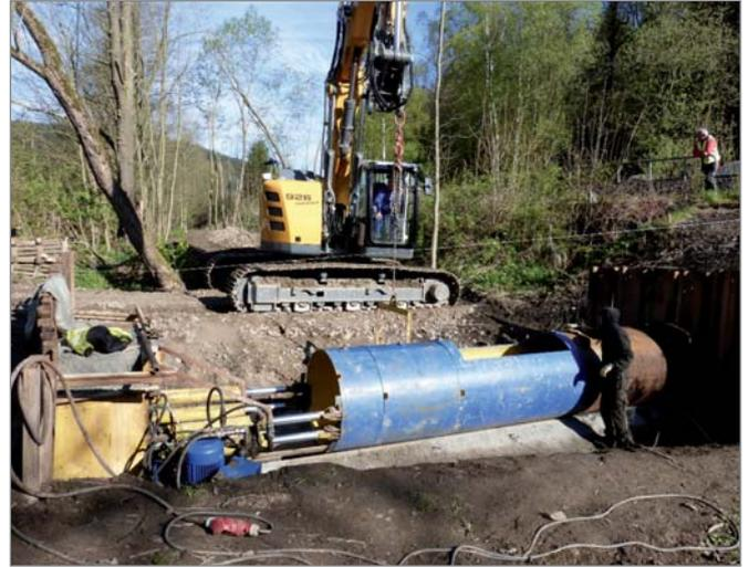
Bild 18: Gegenbohrung DN 1200
