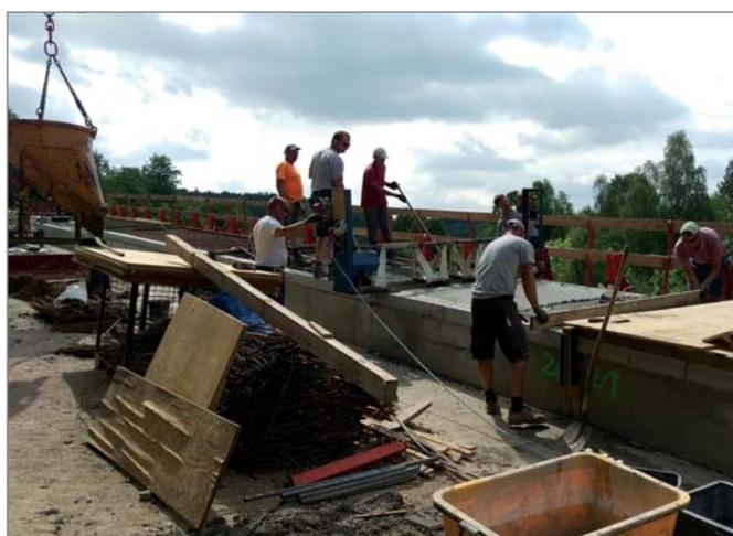
Bild 14: Betonage eines Teilstückes der Kappe
