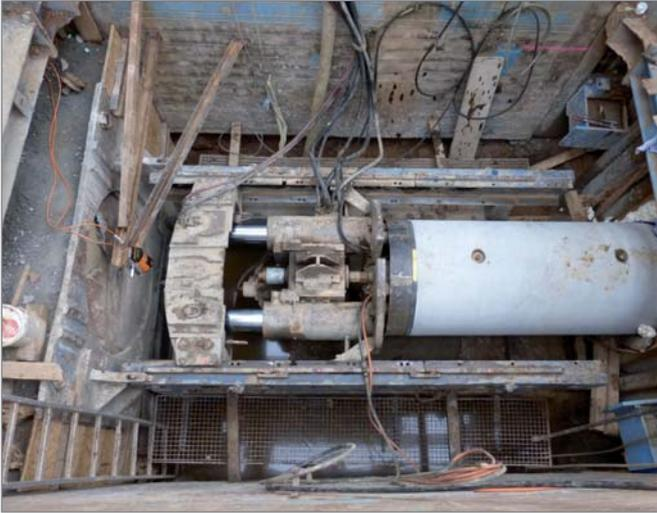
Bild 17: Antrieb und Schiebevorrichtung Microtunneling DN 600
