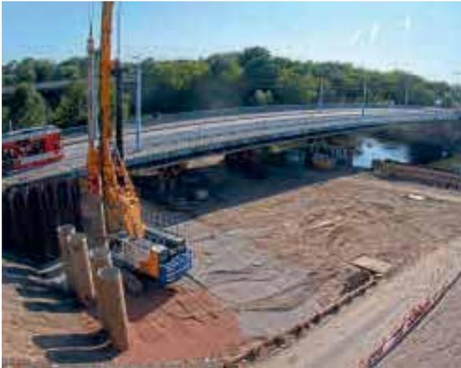
Bild 25: Tiefgründung Achse 40
