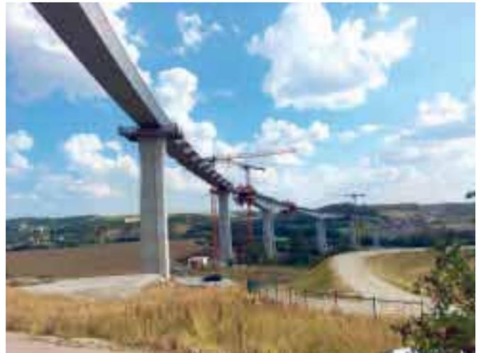
Bild 3: Freivorbau im Bereich des Pfeilers nördlich der Saale
