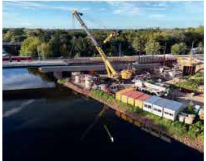
Bild 26: Stahlträgermontage Seite West
