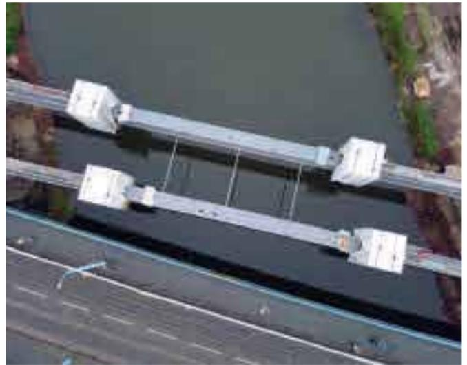
Bild 30: Stahlträgermontage Lückenschluss
