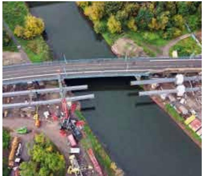
Bild 28: Stahlträgermontage Seite Ost
