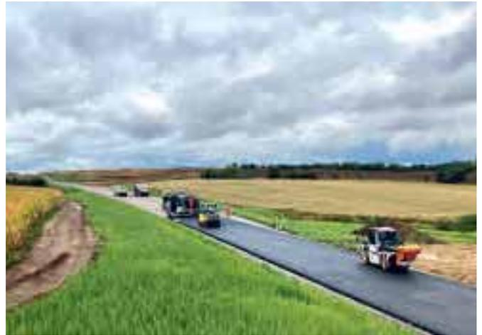
Abbildung 8: Asphaltteinbau B 247 OU Mühlhausen, 2024
