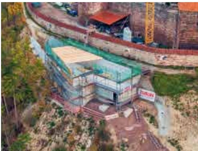
Bild 2: Fertigstellung des Rohbaus der Bergstation des Schrägaufzugs
