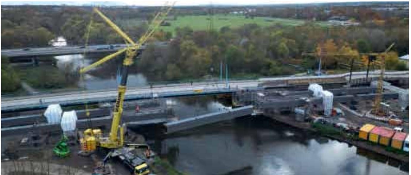
Bild 31: Stahlträgermontage Lückenschluss
