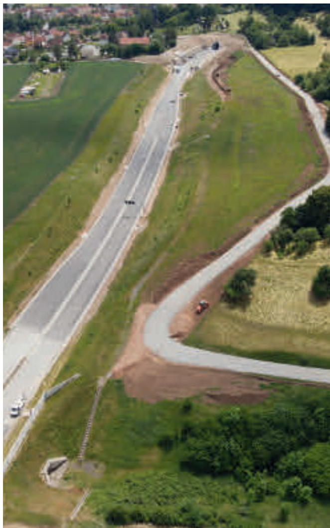
B 88 Einschnitt vor Tunnelnordportal Quelle: IB Oxfort Ingenieure Weimar
