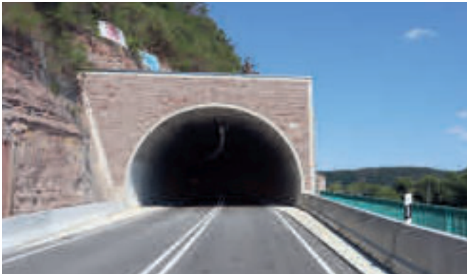
Südportal Tunnel Rothenstein
