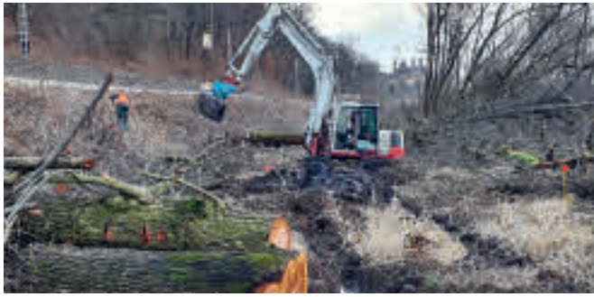
Fäll- und Rodungsarbeiten bei km ca. 54,8 bahnlinks
