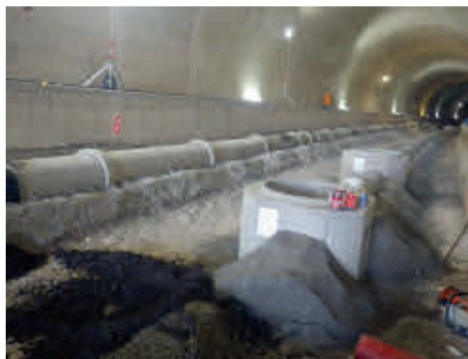
Entwässerungsleitungen im Tunnelquerschnitt
