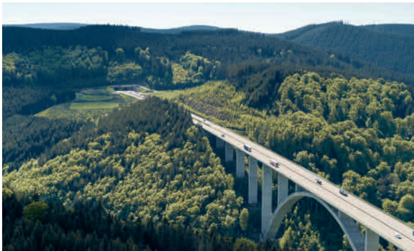
Nordportal Tunnel Rennsteig mit der Talbrücke Wilde Gera
