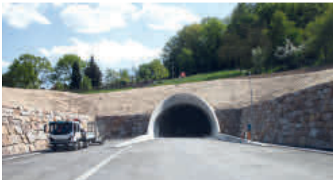
Nördliche Tunnelzufahrt Rothenstein
