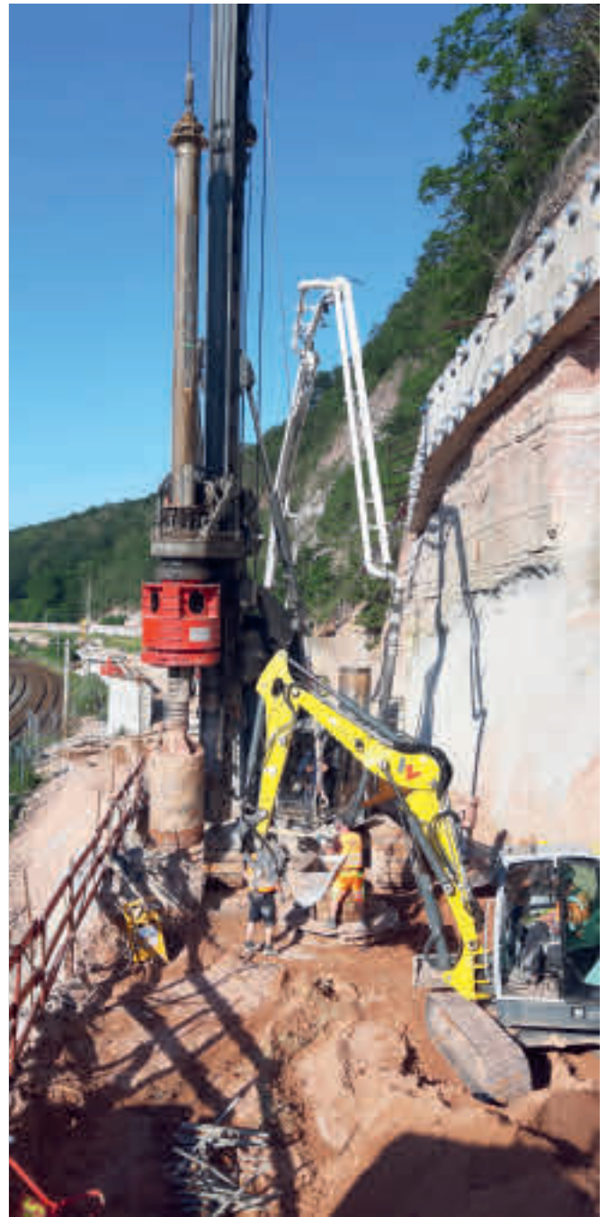
Gründung Südportal Quelle: TLBV/ARGE Tunnel/INGE Tunnel
