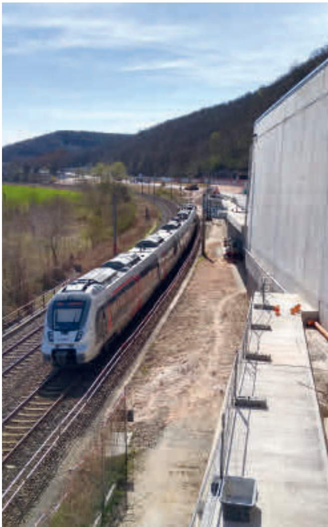
Baufeld Südportal nach Fertigstellung
