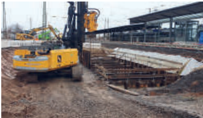
Verbauarbeiten an der PU BA 1
