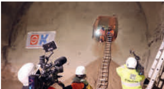
Tunneldurchschlag 06.01.2021, Tunnelpatin Beate Weber Quelle: TLBV
