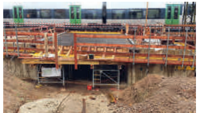
BA 1 EÜ Moorbach, Schal- und Bewehrungsarbeiten
