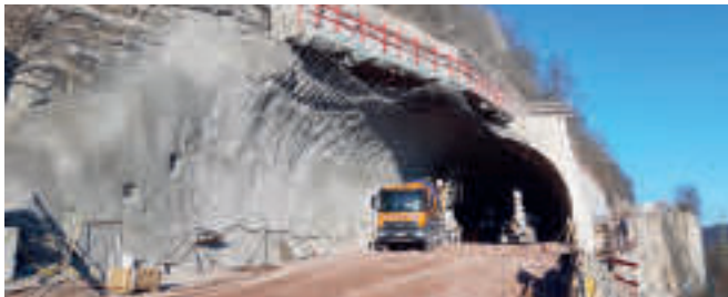
Südportal Unterfahrung Sandsteinmassiv Quelle: TLBV
