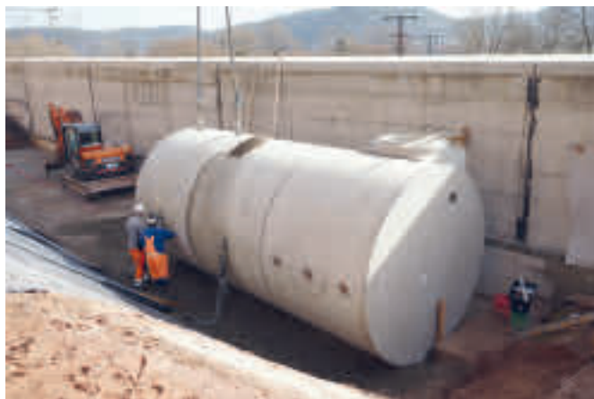
Einbau Schadstoffbecken
