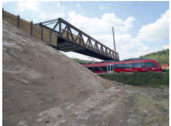
Behelfsbrücke SS 80 für Umleitungsstrecke
