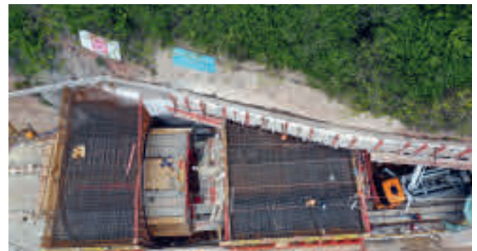
Betonage Südportalblöcke Quelle: TLBV/ARGE Tunnel/INGE Tunnel
