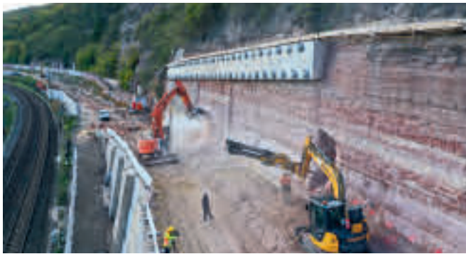
Vorabtrag Gründungsebene Südportal mit Ankerbalken Quelle: TLBV/ARGE Tunnel/INGE Tunnel
