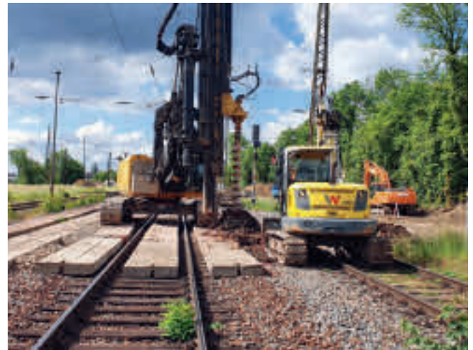
Einbringung Baugrubenverbau EÜ Moorbach BA 1, Blickrichtung zum Bahnhof
