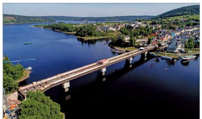
Brücke mit fertiggestellten Überbauabbruch und Beginn Fertigteilmontage
