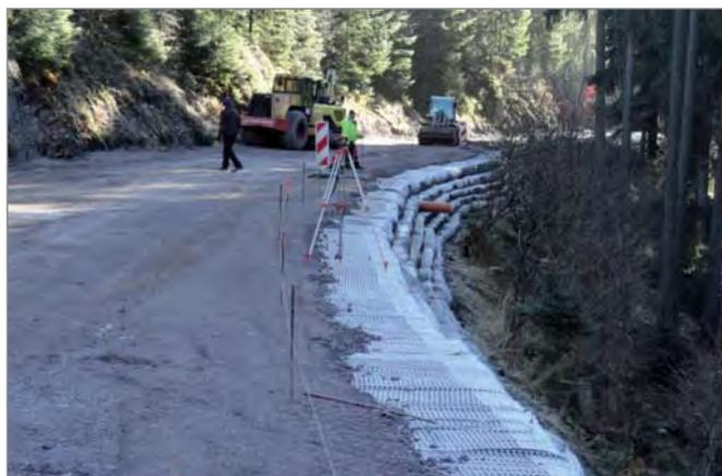
Abbildung 1: Böschungsschultericherung auf voller Fahrbahnbreite im Bau
