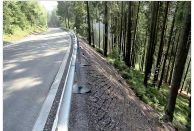
Abbildung 3: Fertiggestellte Böschungsschulterisierung
