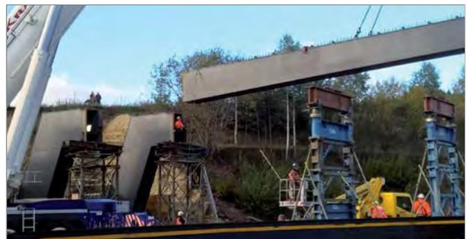
Einbau der Träger Montagstützen auf dem Mittelstreifen der A71
