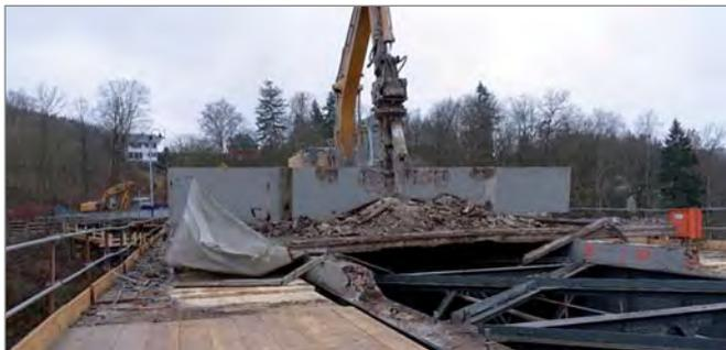
Abbruch der quer vorgespannten Fahrbahnplattenfertigteile
