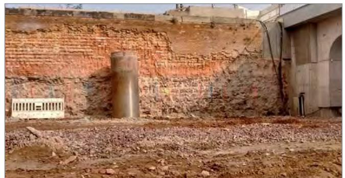
Auf Grund von vergrößerten Bohrpfahldurchmessern mussten die alten Stützwände abgefräht werden.
