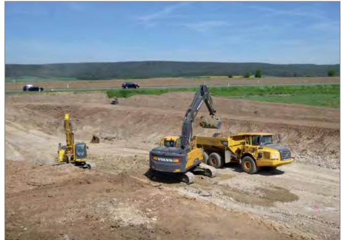
*Bild 12 Lösen des Felsgesteins mit Reißzahn und Verladung auf Muldenkipper*
