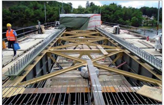
Neuer Brückenüberbau auf alter Unterkonstruktion
