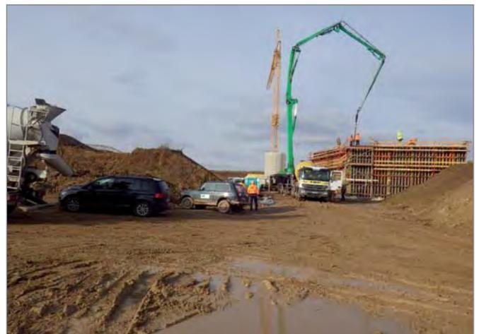
*Bild 13 Betonage westliches Widerlager Bauwerk 1 (Brücke über die K 508n)*
