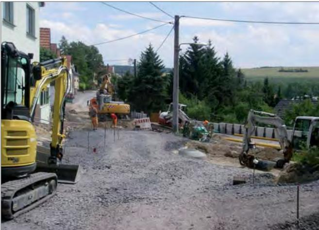
*Bild 10 Einbau der Frostschuttschicht an der Einmündung der Waldstraße in die Alte Landstraße in Neunhofen*
