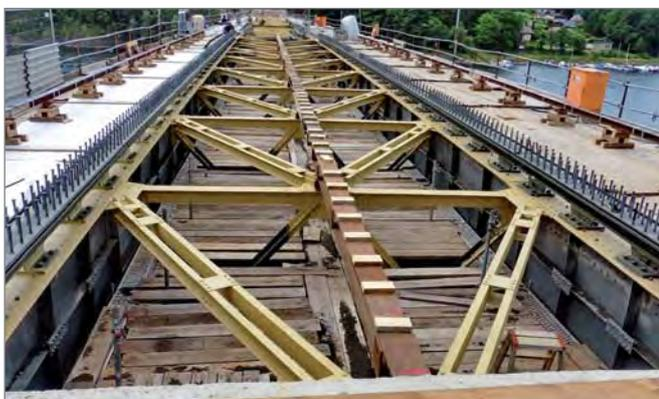
Fertiggestellte Montage der „Stühle“ mit HV-Schrauben und Verschweißung der Längsträger
