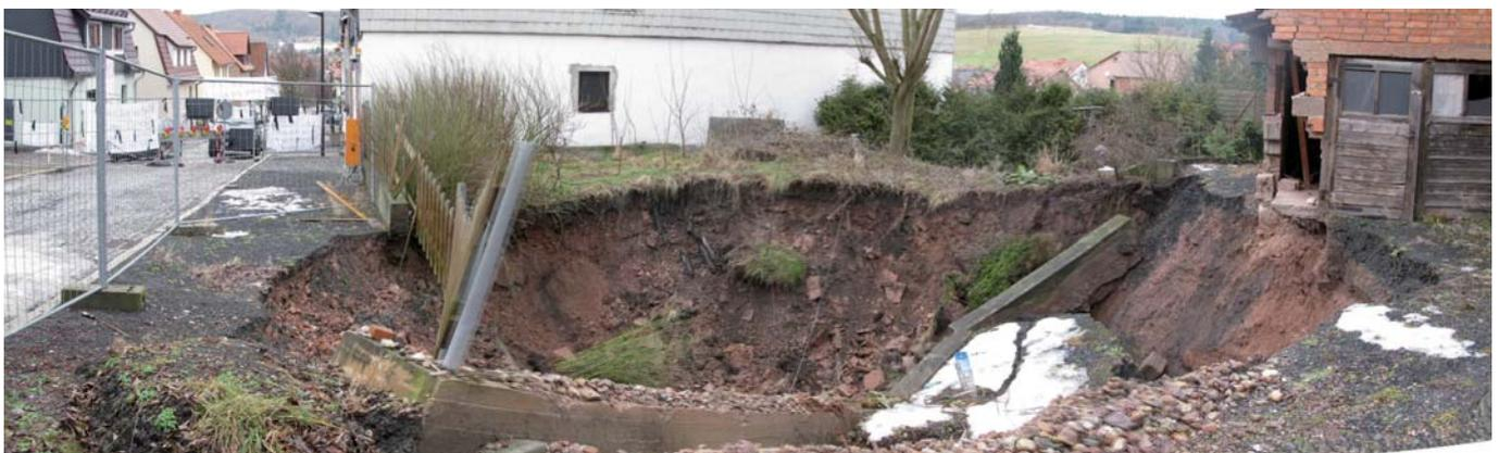
Abb. 10: Am 28.01.2010 ging in der Ortslage von Tiefenort ein Erdfall nieder. Schon 2002 ereignete sich an gleicher Stelle ein etwas kleinerer Erdfall, der in den darauffolgenden Jahren sechs weitere kleine Nachbrüche verzeichnete. Ursache für diesen Erdfall sind Auslaugungsprozesse in 180 m Tiefe (vgl. Abb. 8) im Werra-Steinsalz.
