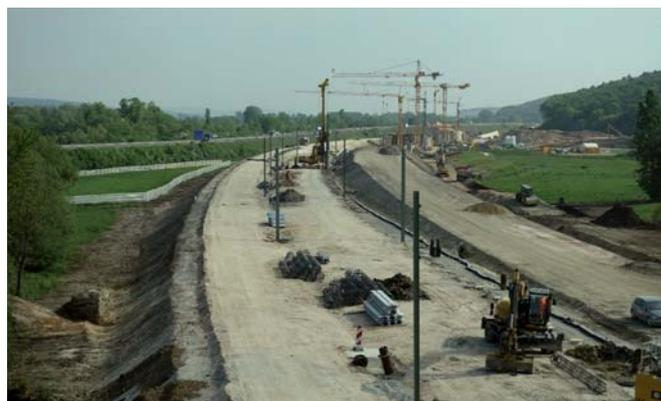
Während einer achtmonatigen Vollsperrung wird der 22 km lange Abschnitt zwischen Hallstadt und Ebensfeld von den bestehenden zwei Gleisen auf vier Gleise erweitert. Würden die Arbeiten „unter rollendem Rad“ stattfinden, nähmen Sie einen Zeitraum von acht Jahren in Anspruch. Künftig werden auf zwei Gleisen Geschwindigkeiten von 200 bis 280 km/h und auf zwei Gleisen 160 km/h möglich sein.
