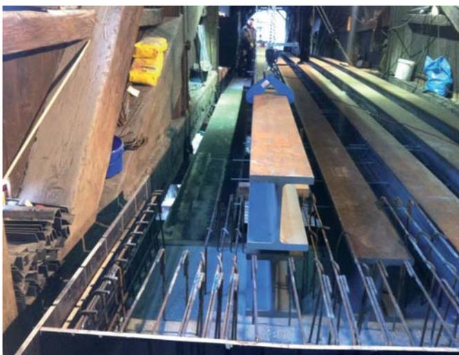
Um die Standsicherheit, Dauerhaftigkeit und Verkehrssicherheit wiederherzustellen und die Tragfähigkeit auf mindestens 7,5 t zu erhöhen, wurde seit 2010 die Instandsetzung und Verstärkung der
