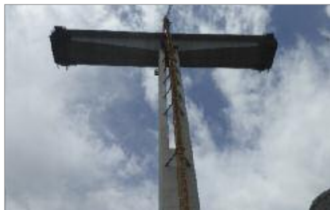
Bilder 2 u. 3: Besuch auf der Baustelle Brücke über die Moraca-Schlucht
