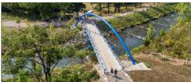
© Stadtverwaltung Erfurt Mit bis zu zehn Prozent Steigung und baulichen Mängeln entspricht die bestehende Fußgänger- und Radwegbrücke nicht den aktuellen Anforderungen. Hier entsteht ein barrierefreier Ersatzneubau.
