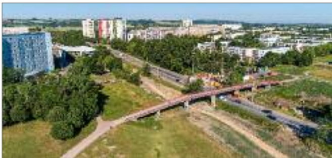
© Stadtverwaltung Erfurt Mit bis zu zehn Prozent Steigung und baulichen Mängeln entspricht die bestehende Fußgänger- und Radwegbrücke nicht den aktuellen Anforderungen. Hier entsteht ein barrierefreier Ersatzneubau.
