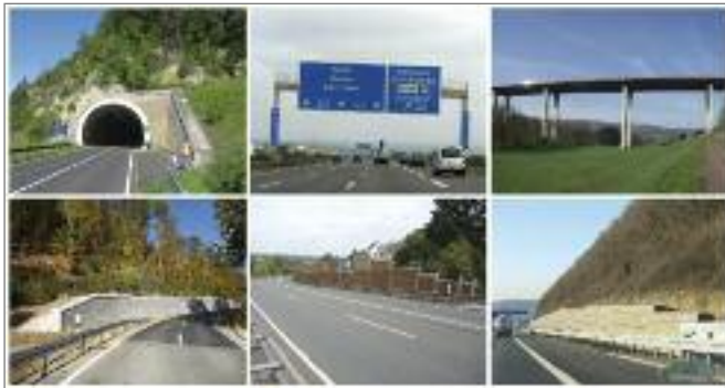
Bild 5: Ingenieurbauwerke nach DIN 1076
