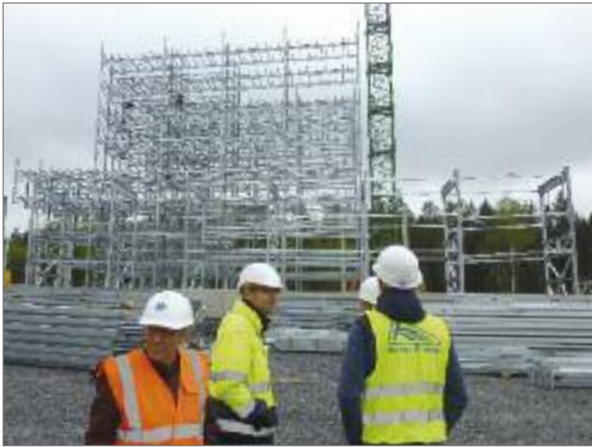
Blick auf das Hochregallager
