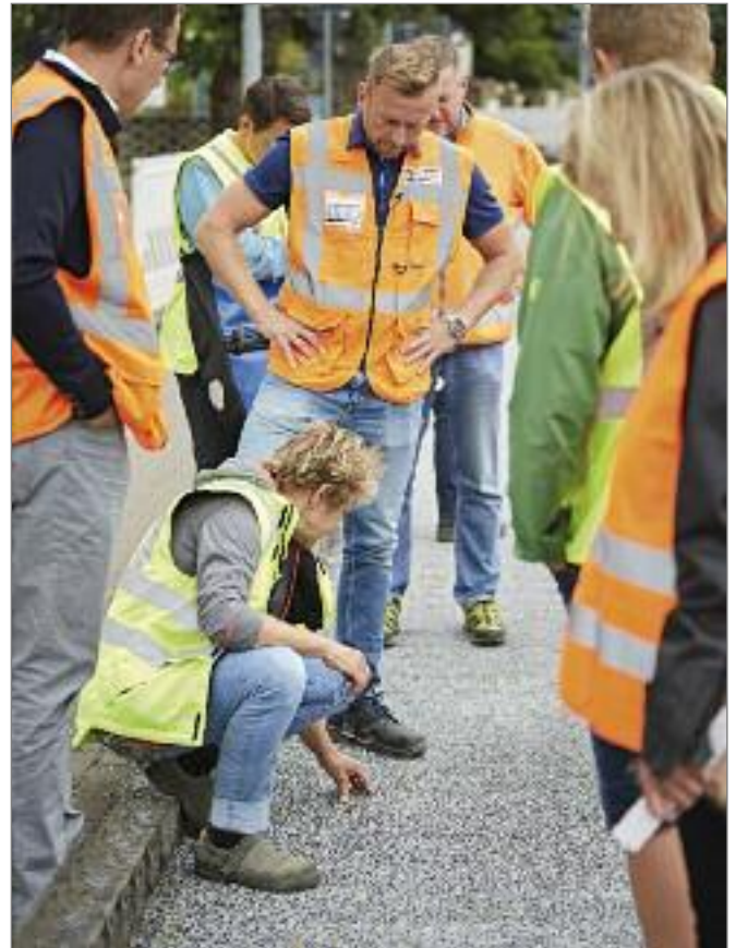
Der Asphalt mit innovativem Abstreumaterial macht die Straßenoberfläche griffig, hellt sie auf und bindet Luftschadstoffe.
