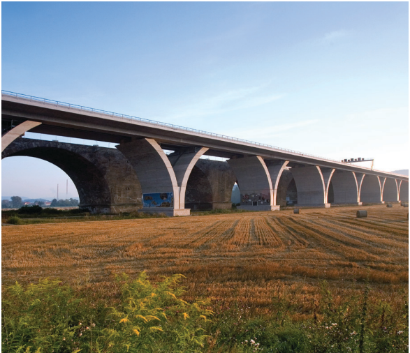
Saaletalbrücke bei Jena-Göschwitz | © Foto: Ingenieurbüro Kleb GmbH
