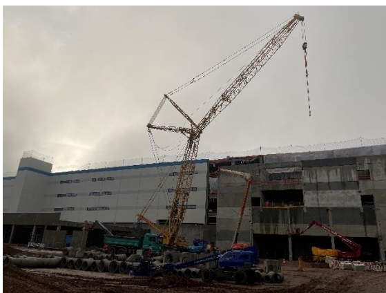
Ansicht aus östlicher Richtung, hier entsteht gerade der Verwaltungsbereich
