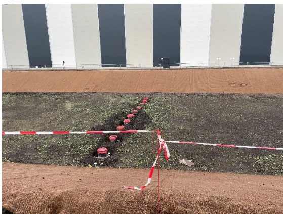
bereits fertiggestelltes Versickerungsbecken
