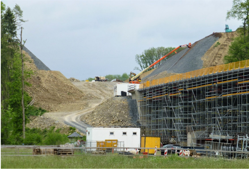
Erster Teilabtrag des Einschnittes nach ca. der Hälfte
