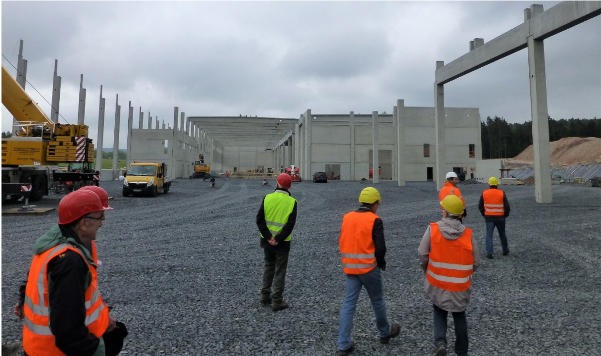
Die zukünftige Produktionshalle mit Fertigteilen der Fa. Angermüller
