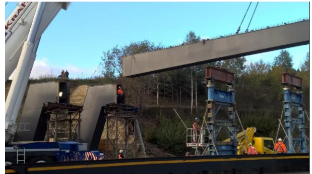
Einbau der Träger Montagestützen auf dem Mittelstreifen der A71
