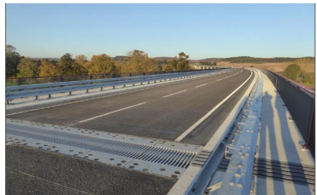
Fertige Brückentafel mit Übergangskonstruktion
