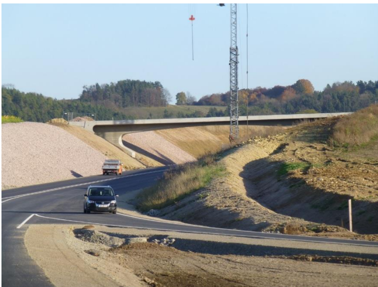
Einschnittbereich mit Überführungsbauwerk
