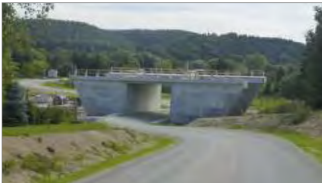
Bild 9: Neuer Rad- / Wirtschaftsweg zur Anbindung des Saaleradweges in die OL Zeutsch, Quelle: TLBV
