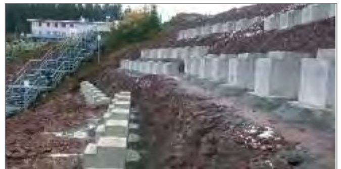
Gründung der mobilen Tribünen durch Einzelfundament
