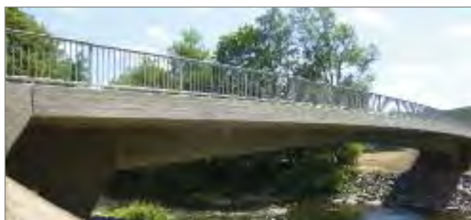
Bild 22: Bauwerk 8 Wirtschaftswegbrücke über die Saale, Quelle: TLBV
