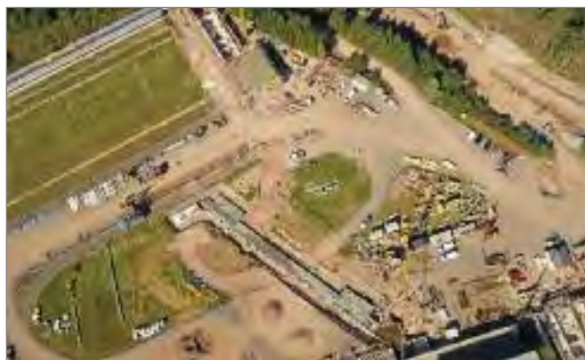
Übersicht über die Baustellen der Wirtschafts- und Technikgebäude mittels Drohnenflug
