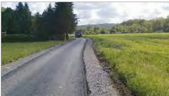
Bild 10: Neuer Radweg entlang der Saale unterhalb von Orlamünde, Quelle: TLBV
