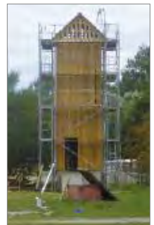
Bild 24: Neubau Schlauchturm Quelle: TLBV
