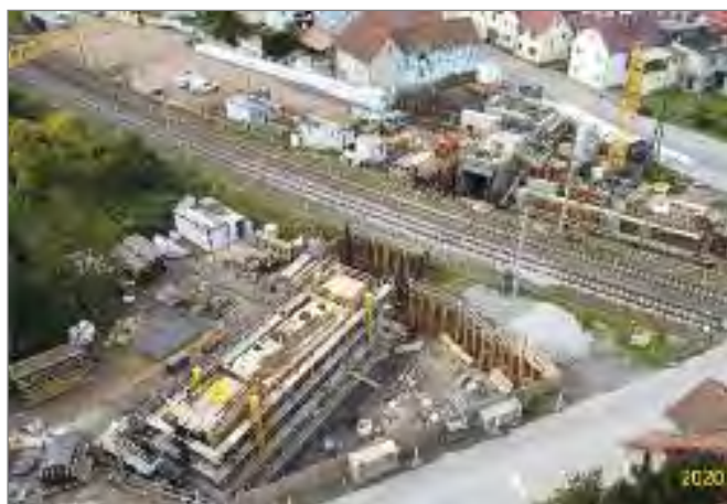
Bild 16: BW 03 hinten in Endlage BW 04 vorne für Längsverschub Quelle: IB BBV, Hr. Hidde
