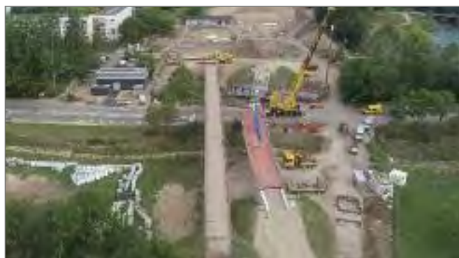
Einheben der Brückenteile im August 2020
