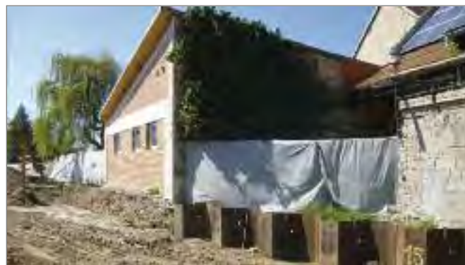
Bild 32: Verbau und teilgesichertes Gebäude an der OU Zeutsch Quelle: TLBV
