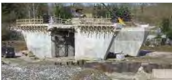
Bild 26: Neubau BW 01, Quelle: TLBV
