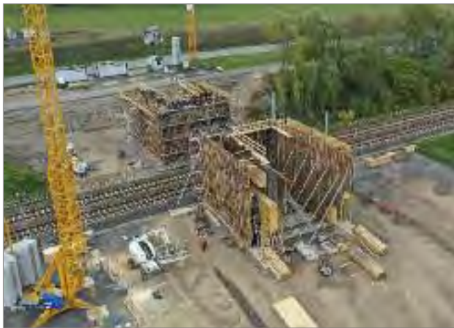
Bild 19: BW 05 Widerlager Einbau Bewehrung, Quelle: IB BBV, Hr. Hidde
