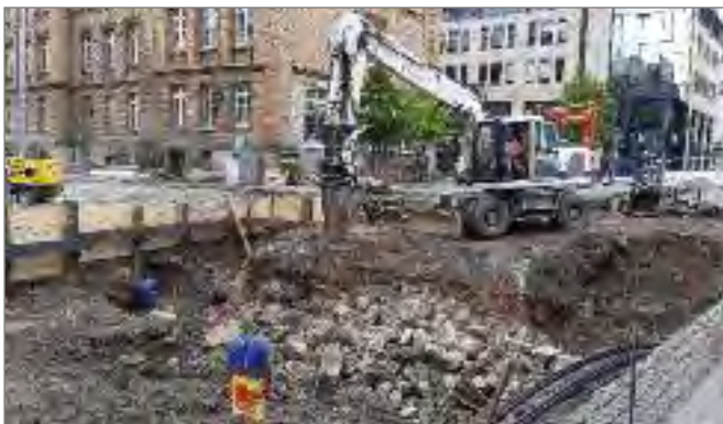
Sonntag, 02.08.2020: Die Gleise waren weg, der Bagger grub sich durch das Gestein der Tunnelröhre, in der die abgeklemmten Trinkwasserleitungen verliefen.
