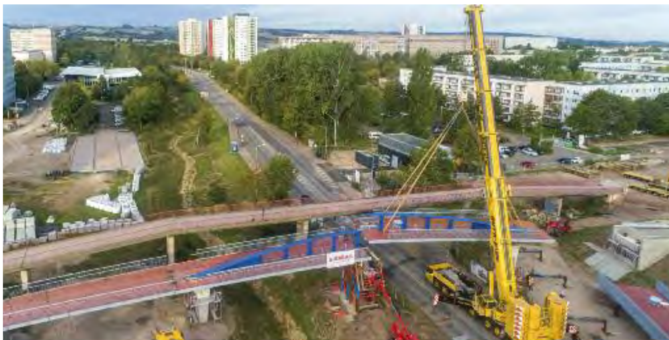
Ende August 2020 wurden die Teile für die neue Brücke eingehoben.
