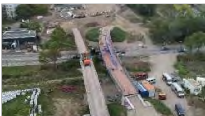
Abriss der alten Brücke im September 2020
