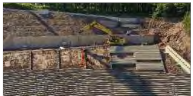
Stufenmontage der Tribünenerweiterung
