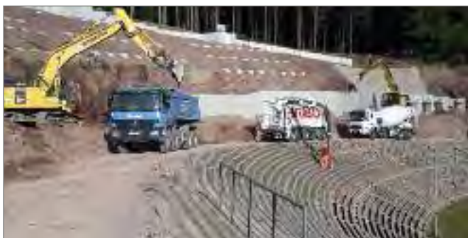
Abtragen des Schotteraufbaus in den vorhandenen Tribünelementen mittels Saugbagger
