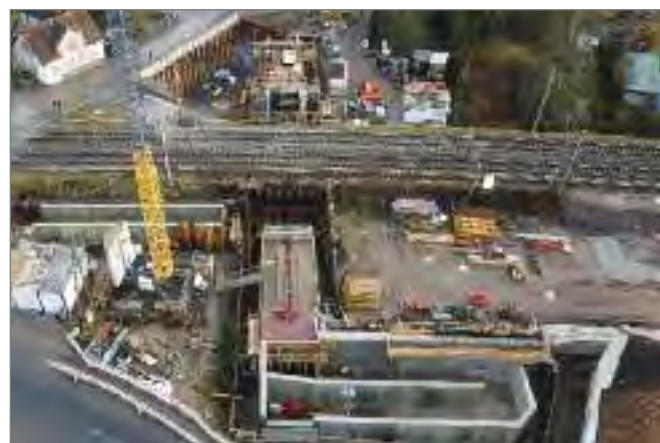
Bild 17: Rampe zu BW 03 auf Zeutscher Seite Quelle: IB BBV, Hr. Hidde
