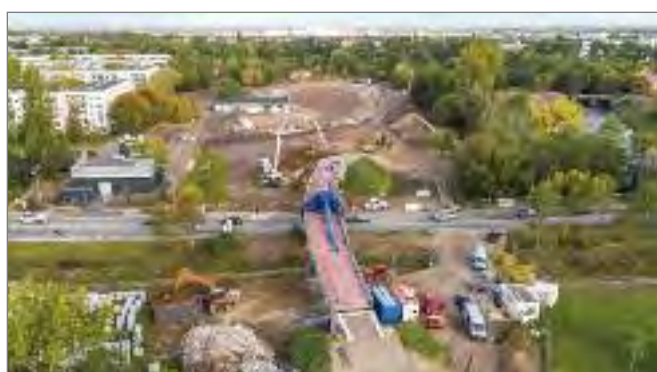
neue Brücke im Oktober 2020
