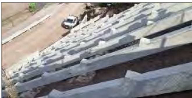
Bühnenträgermontage für die mobile Tribünen
