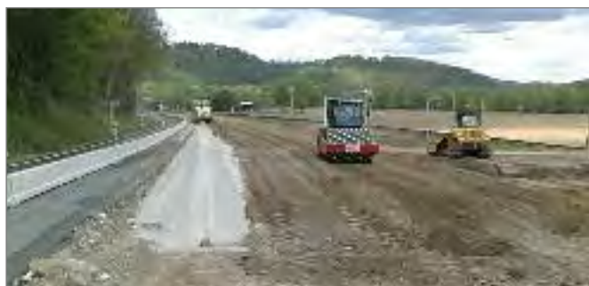
Bild 31: Bodenverbesserung auf B 88 unter halbseitiger Bauweise Quelle: TLBV
