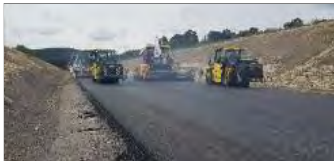
Bild 28: Asphalteinbau Zeutsch – Uhlstädt Quelle: IB Knappe
