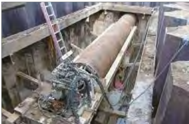
Bild 25: Pressung Schutzrohr Vorflutleitung Quelle: TLBV
