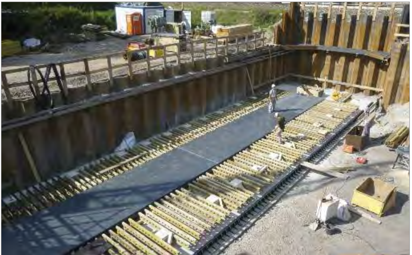
Bild 34: Herstellung BW 04 Verschubbahn, Quelle: TLBV
