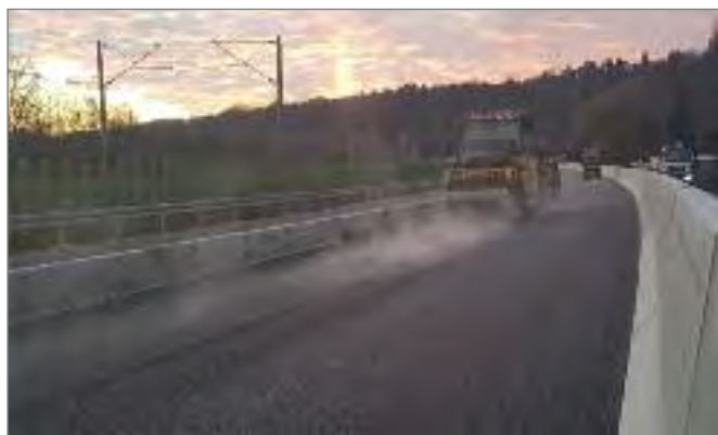
Bild 30: Asphaltbau halbseitig im Bereich Orlamünde Quelle: IB Knappe
