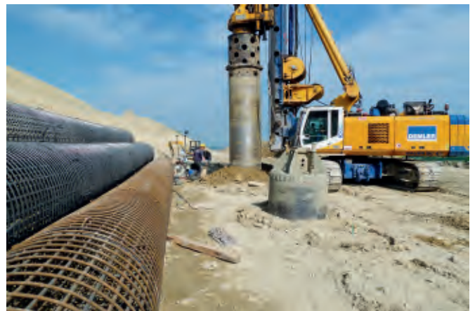
Bild 7: Herstellung der Dübelbohrpfähle im Mai 2011
