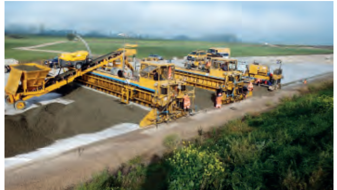
Betonfertiger Foto © Ingenieurbüro Prof. Dr.-Ing. H. Bechert + Partner
