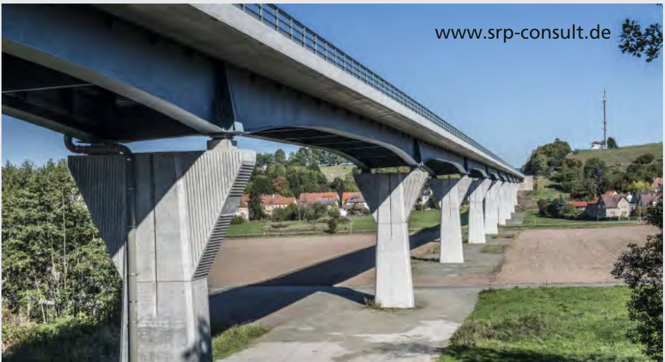
B 19, Talbrücke Schmalkalden
