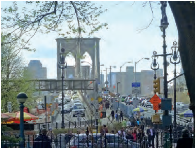
Bild 27: Brooklyn Bridge, Zufahrtsrampen
