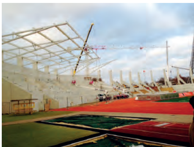
Blick auf Tribüne und Überdachung
