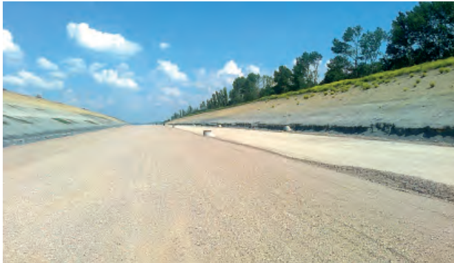
Trasse im Einschnitt mit Frostschuttschicht Foto © Thüringer Landesamt für Bau und Verkehr
