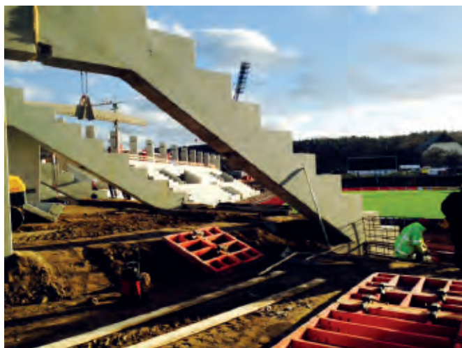
Multifunktionsarena Erfurt: im Bau befindliche Tribüne
