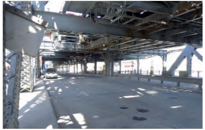
Bild 38: Broadway- Hubbrücke, Fahrbahnen
