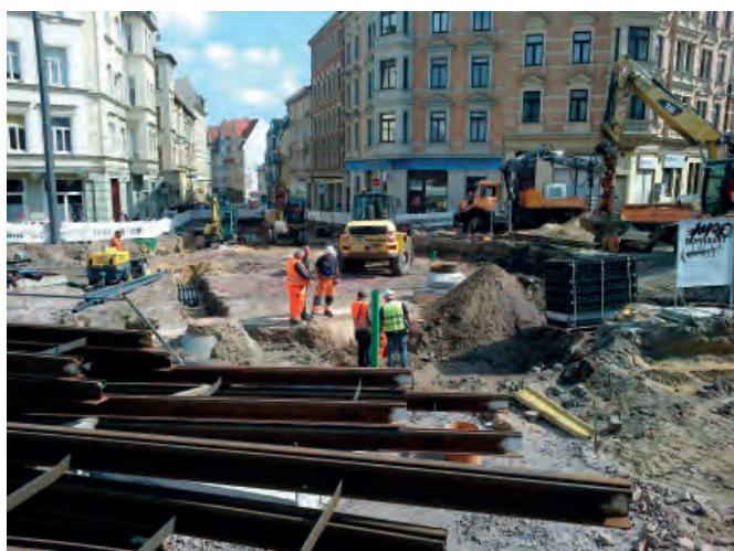
Die Baustelle „Rannischer Platz“ in Halle
