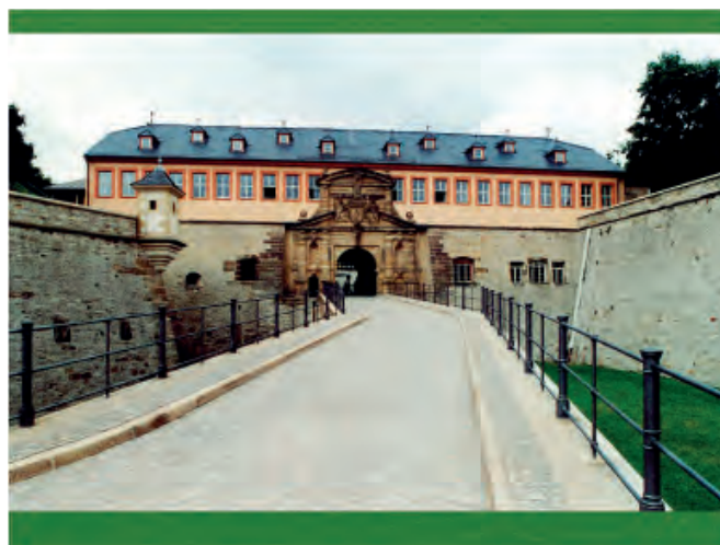
Abb. 2: Zufahrtsbrücke mit Peterstor und Kommandantenhaus
