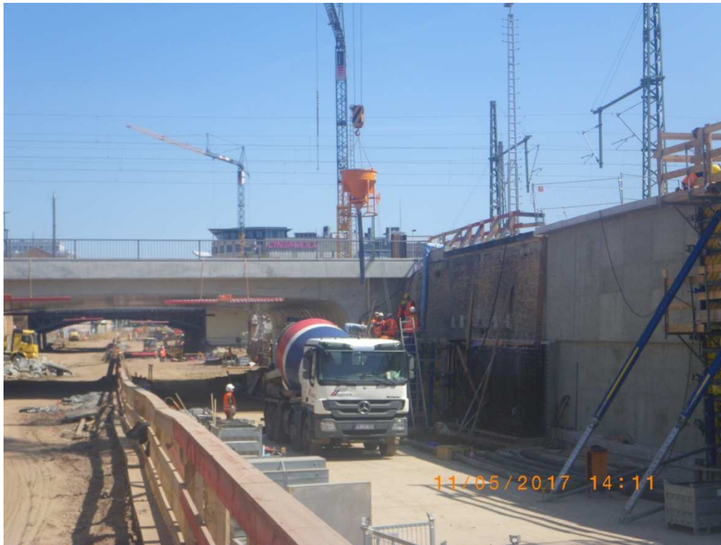
Betonage Stützwand
