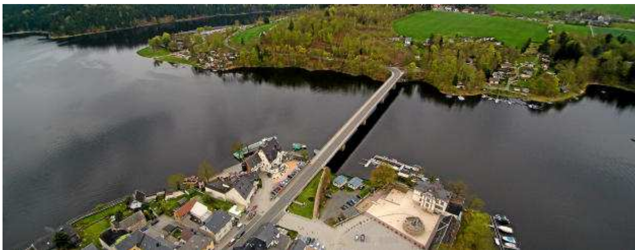
Saalburg-Ebersdorf. Die Brücke über die Saale bei Saalburg wird fast das gesamte Jahr 2017 voll
